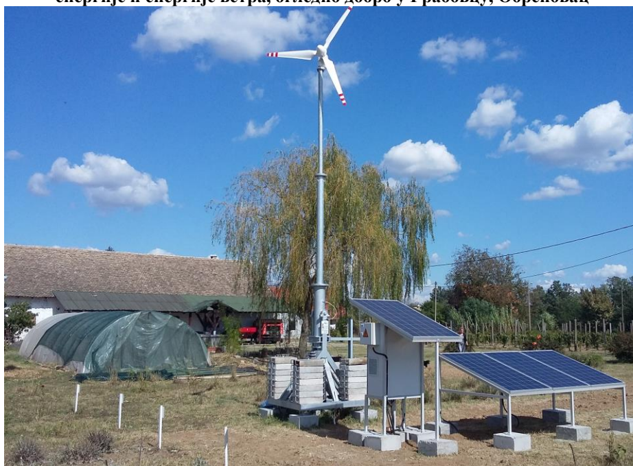
Слика 2. Хибридни систем снабдевања енергијом когенерацијом сунчеве и енергије и енергије ветра, огледно добро у Грабовцу, Обреновац
